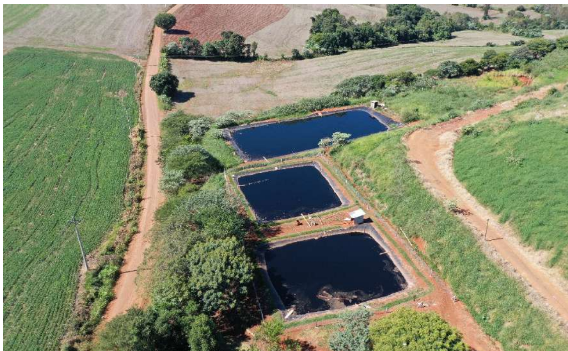
Figura 20 - Estação de tratamento de efluentes líquidos.
